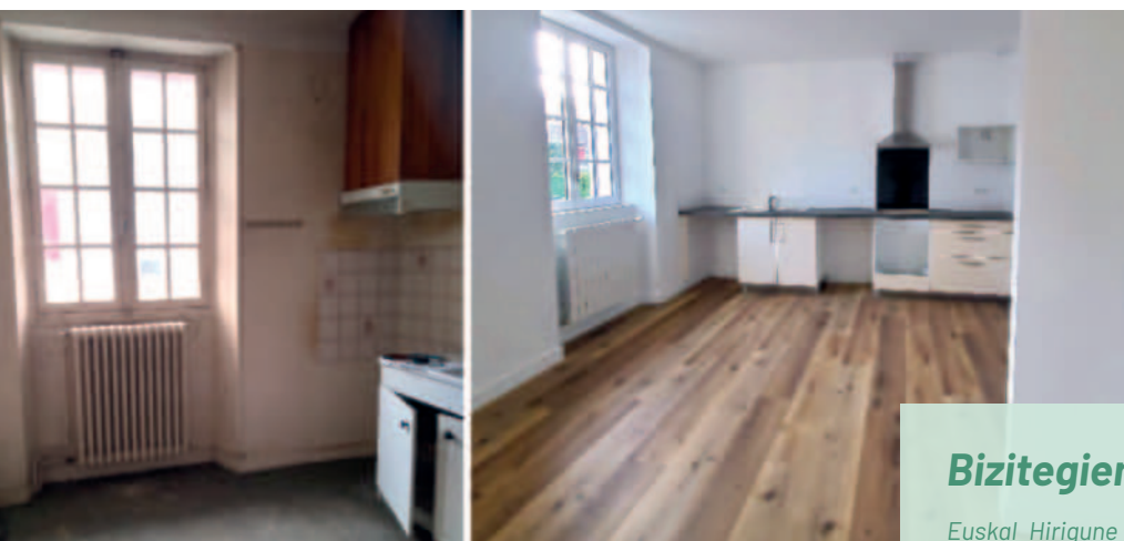
Rénovation du logement de la Poste (avant-après)
